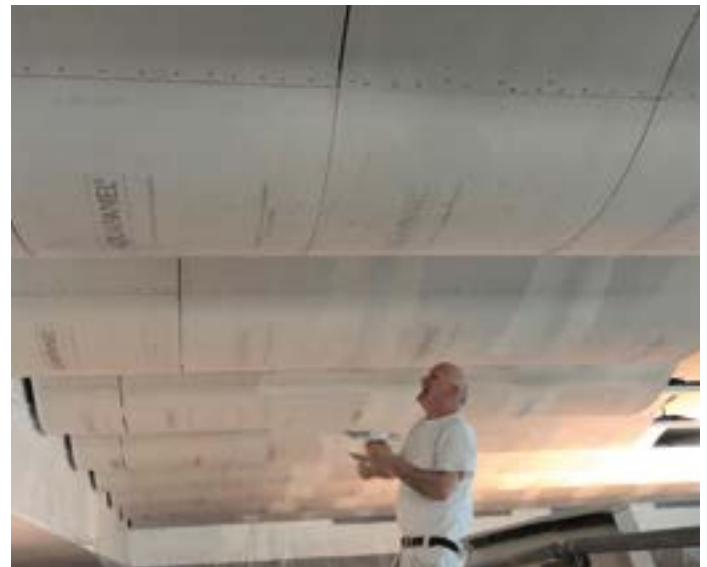
Dank ihrer Feuchteunempfindlichkeit, des geringen Gewichts und der einfachen Biegefähigkeit eignet sich die AQUAPANEL® Cement Board SkyLite optimal für solche Anforderungen
