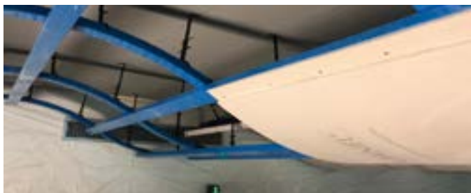
Die darunterliegende Unterkonstruktion für die Wellensegel besteht ebenfalls aus C5-M Profilen, an denen die Deckenplatten befestigt wurden
