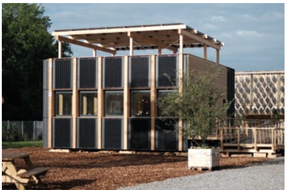
Auf dem Solar-Campus haben 13 Hochschulteams Gebäude-Demonstratoren gebaut
