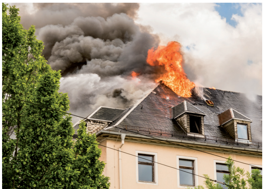
Gebäudebrände werden immer wieder durch Dacharbeiten verursacht.
